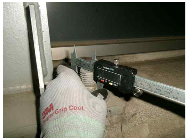
기초연결부 볼트 부재치수 현장측정
