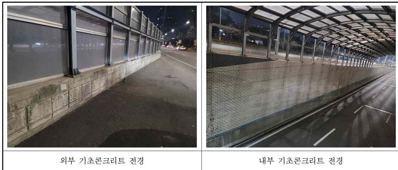
【사진 3.4.7】 기초콘크리트 전경
