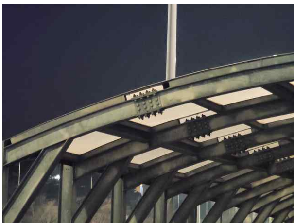
S02 주골조 연결부 상태현황
