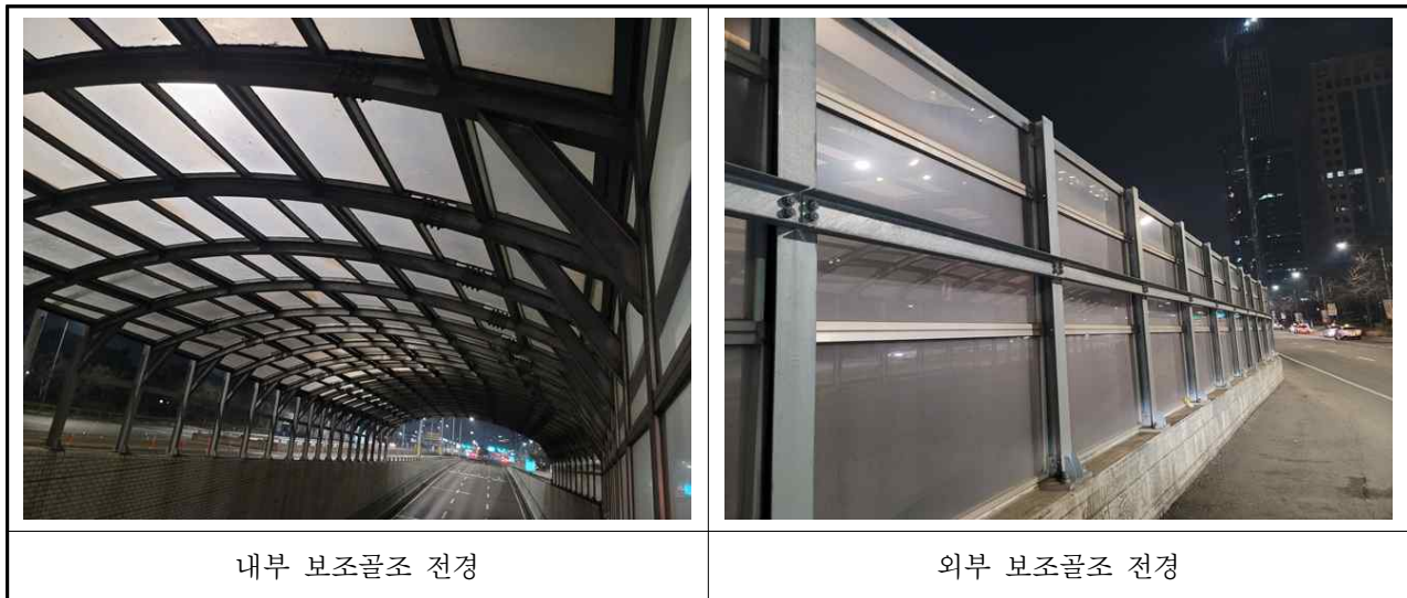
【사진 3.4.3】 보조골조 전경
