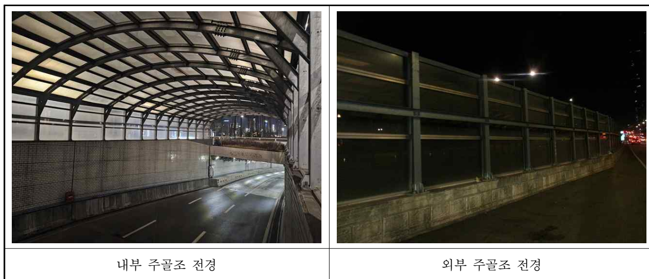
【사진 3.4.1】 주골조 전경
