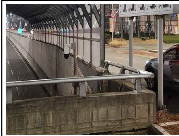
안전 및 기타시설(진입 접속부 가드레일) 상태현황
