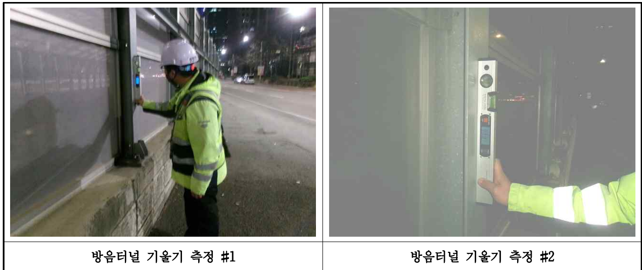
【사진 3.6.3】 경사계를 이용한 기울기 측정 현장사진
